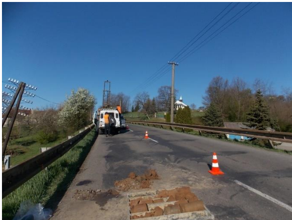
Obrázok 2 Vrtý a sondy na ceste II/526 v km 4,152-4,290 v obci Bzovík
